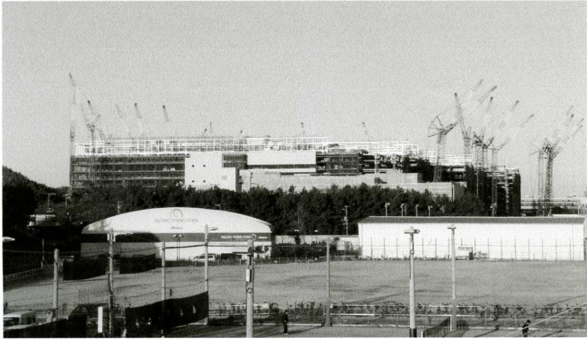
武田薬品研究所の全体の様子(JR 東海道線の跨線橋より) 2月9日撮影(小林)
