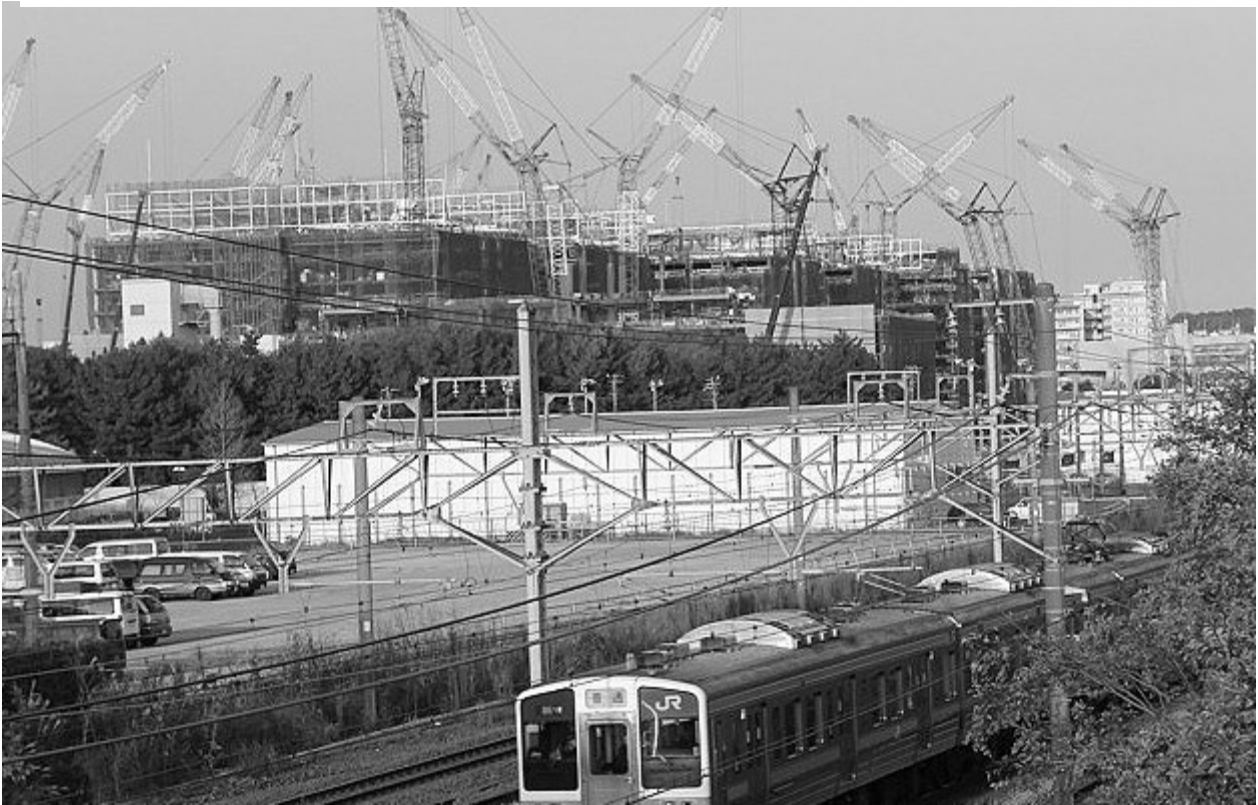
工事が進んでいる武田薬品研究所(JR 東海道線が手前を走る) 11月26日撮影(小林)
