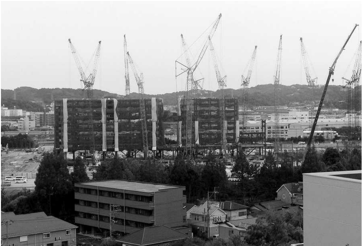
人口密集地に急ピッチで工事が進められている武田薬品研究所(北側から9/22小林撮影)
